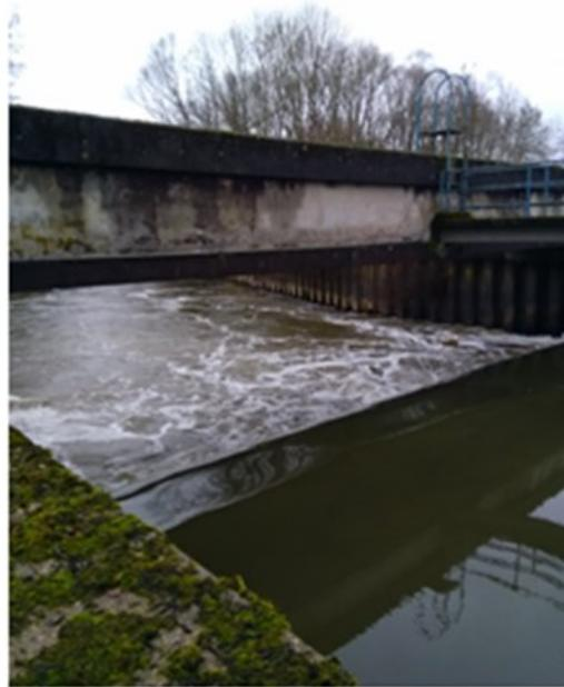
Figure 2: Le seuil présent sur la Chiers avec la passerelle de service en surplomb
