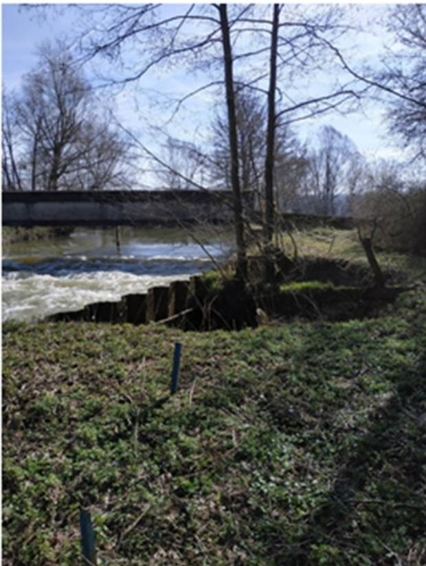
Figure 3 : Sol à l'arrière des palplanches qui se vident par le fond.
